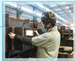
■超音波探傷検査
