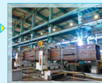
■ロボット柱大組溶接
