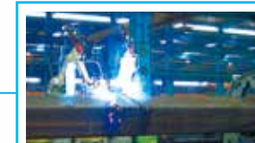
■ロボット柱大組溶接
