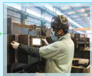
■超音波探傷検査
